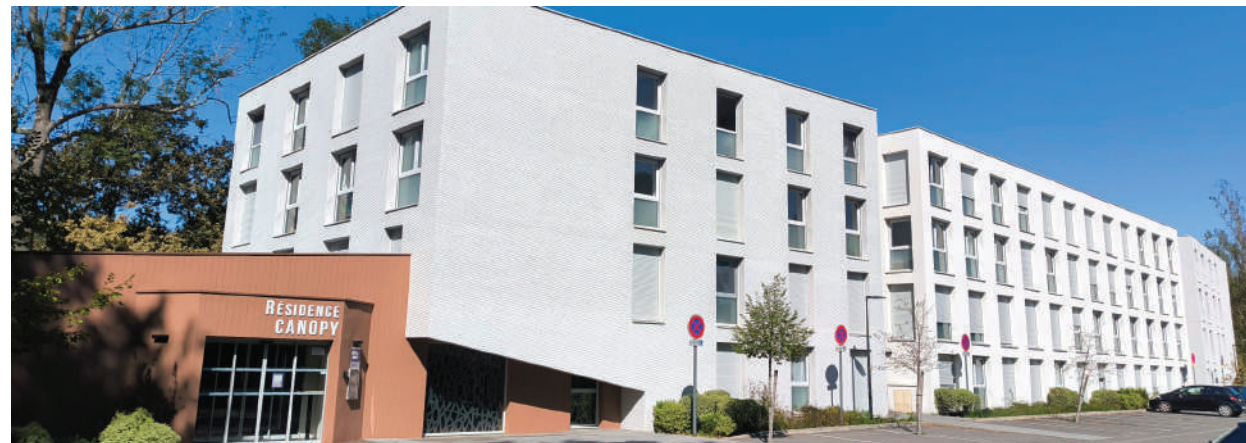
↑ Résidence étudiante (64). Architecte Soho Aquitaine
