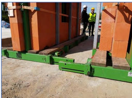
FIGURE 17 : STABILISATEURS POUR STOCKAGE AU SOL DES BOXES
