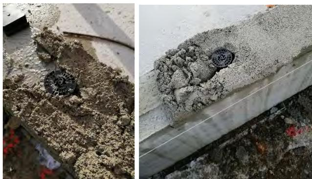
FIGURE 13 : CALES D'ÉPAISSEUR BOUYER LEROUX ET EXEMPLES D'UTILISATION
