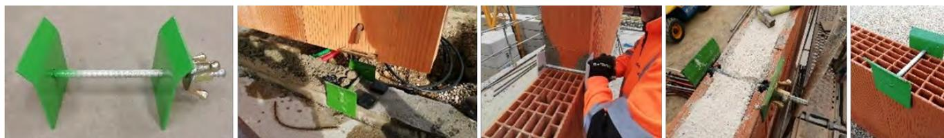
FIGURE 15 : CAVALIER GUIDE ET EXEMPLES D'UTILISATION
