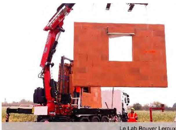
FIGURE 20 : EXEMPLE DE POSE D'UN MUR
