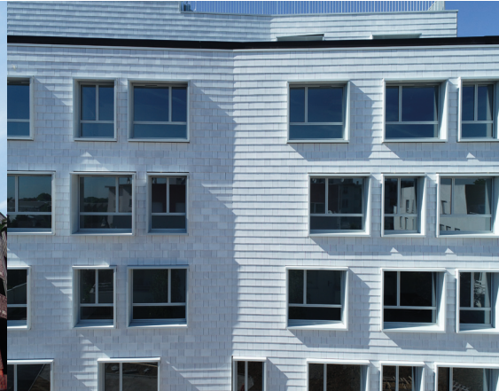
Résidence "Les maisons de Marianne" Architecte : Atelier WOA Finition émaillée Ville : La Courneuve (dépt 93)
