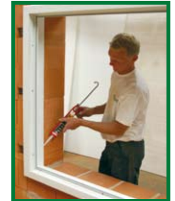
▲ Réalisation de l'étanchéité extérieure
