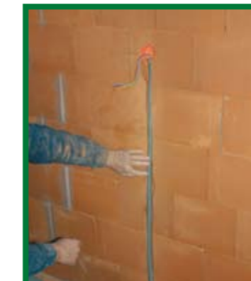
▼ 5 Pose de la gaine
