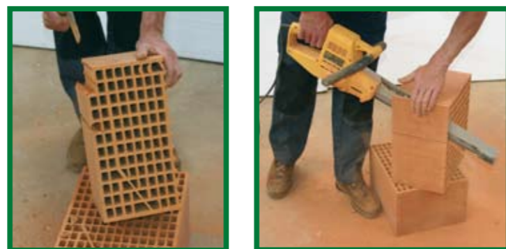
Réalisation de la feuillure à l'aide d'une hachette ou d'une scie
