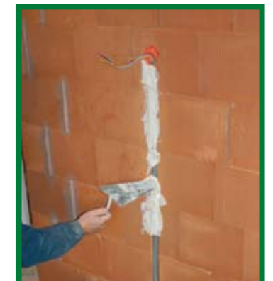
▼ 6 Rebouchage au plâtre
