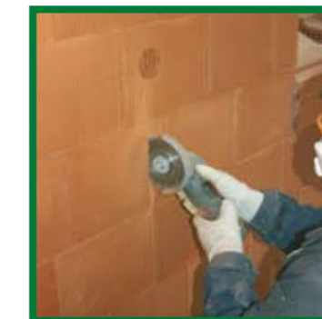
▼ 2 Découpe de la brique (largeur de la gaine, 3 cm de profondeur)
