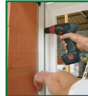
▲ Fixation de la glissière sur le bout de la tapée
