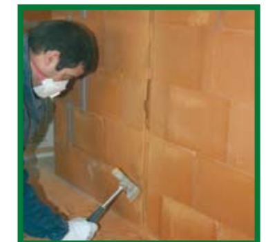
▼ 3 Décaisser la brique à l'aide de la hachette
