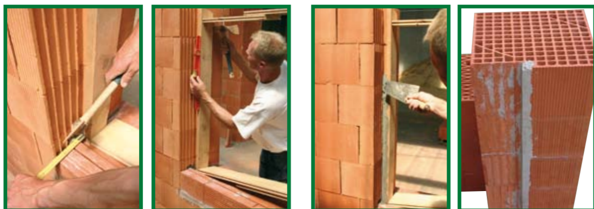
Réglage de la profondeur exacte d'encastrement de la menuiserie dans le mur (145 mm en finition plâtre et 140 mm en finition plaque de plâtre)
