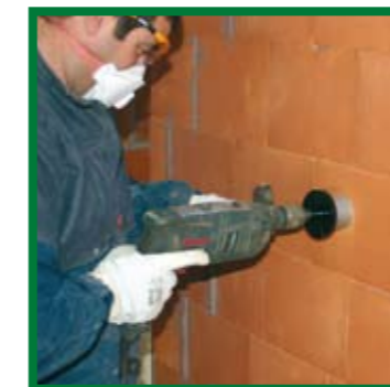
▼ 1 Réalisation de la réservation du boîtier
